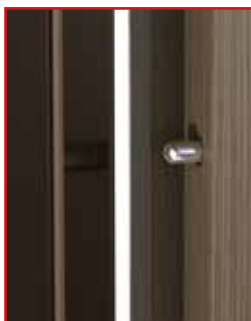
tři bezpečnostní trny proti vysazení KWARC model III
